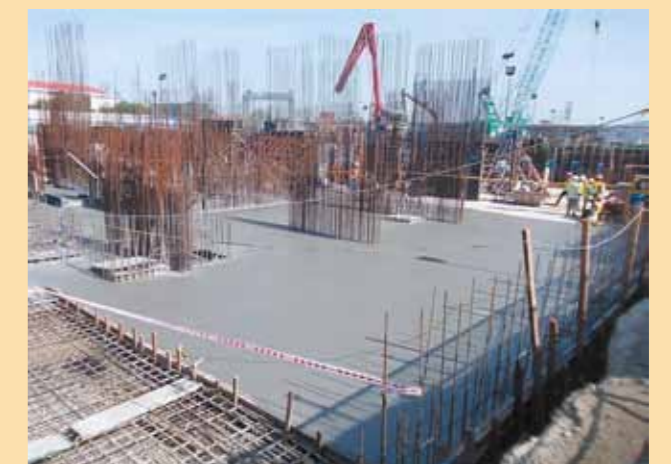
Toàn cảnh tiến độ xây dựng tại Công trình dự án Riviera Point
